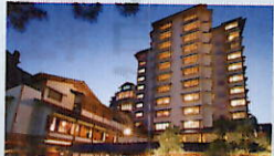
石川県和倉温泉「加賀屋」 全室に採用。
